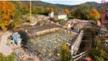
PERI UP ließ sich bedarfsweise mit MULTIPROP kombinieren. Dadurch konnte das Gesamt-Tragsystem optimal an die komplexe Geometrie und die abzutragenden Lasten angepasst werden.
