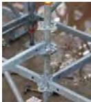
Rasterfrei: Die Klemmrosette UEV erlaubt den Riegelanschluss an einen Vertikalstiel an beliebiger Stelle.
